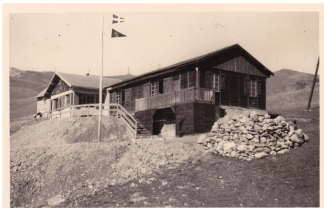
1961. 1953. Travail terminé pour l'ave-
