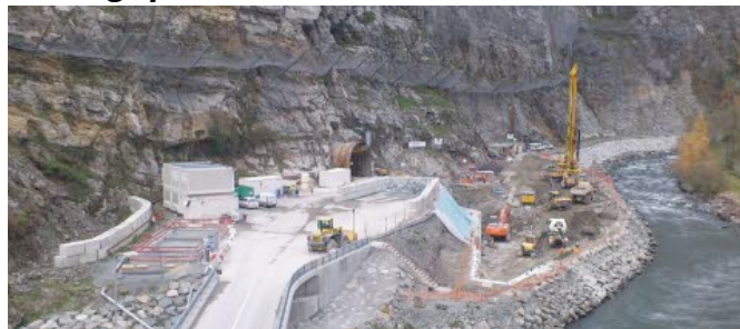
Photo chantier. Dauphiné libéré sur le net
