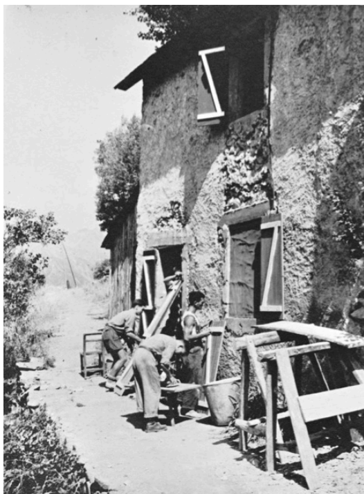
Travaux d'aménagements en 1949
